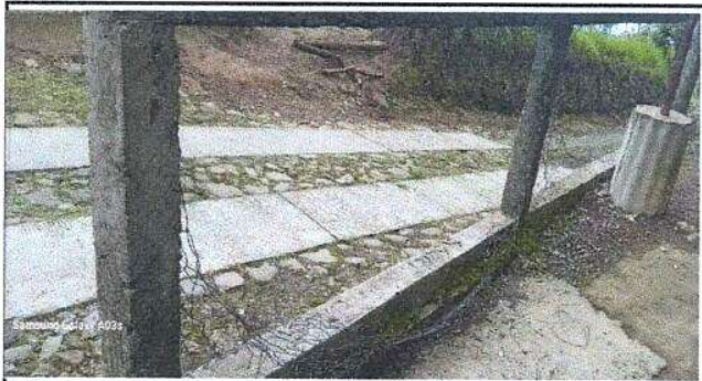
Foto 3: Reparación de muro perimetral de blok
